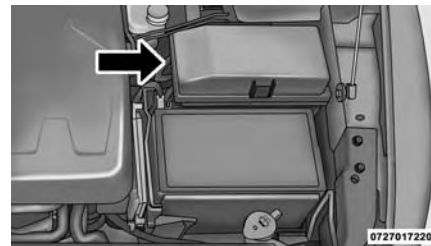
Centro de distribución de tensión
