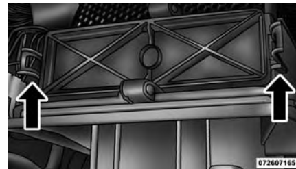
Cambio del filtro de aire del A/A
