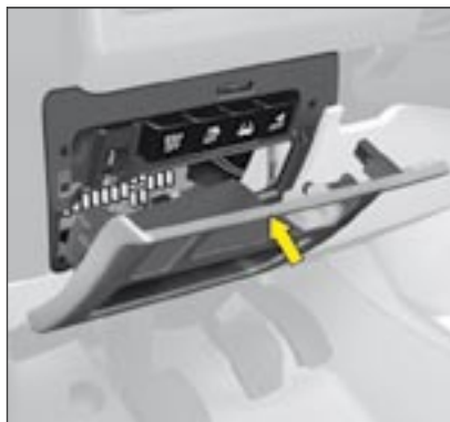
Acceso a la primera caja de fusibles bajo el salpicadero
