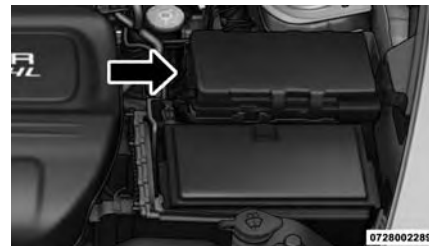
Centro de distribución de energía
