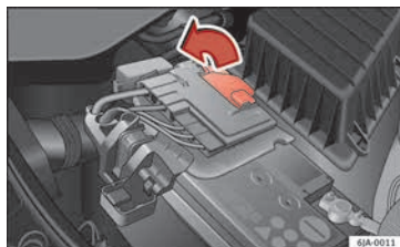
Fig. 211 Batería: apertura de la cubierta.
